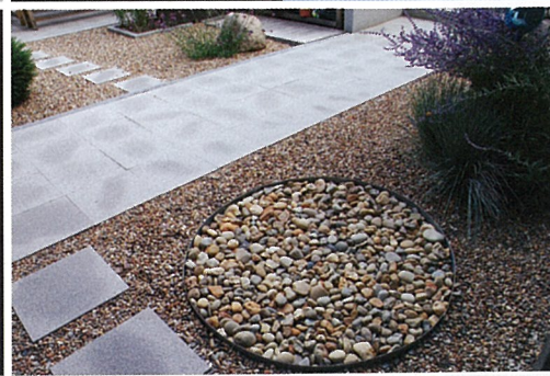
左上：よるい戸のディテール。台形断面の角材を並べている 左下：シンプルなスチールサッシのディテール 右上：軒先部分のといを見上げる。といを持ち出して雨水を直接落とす 右下：といから落ちる雨水を受ける円形の浸透マス
